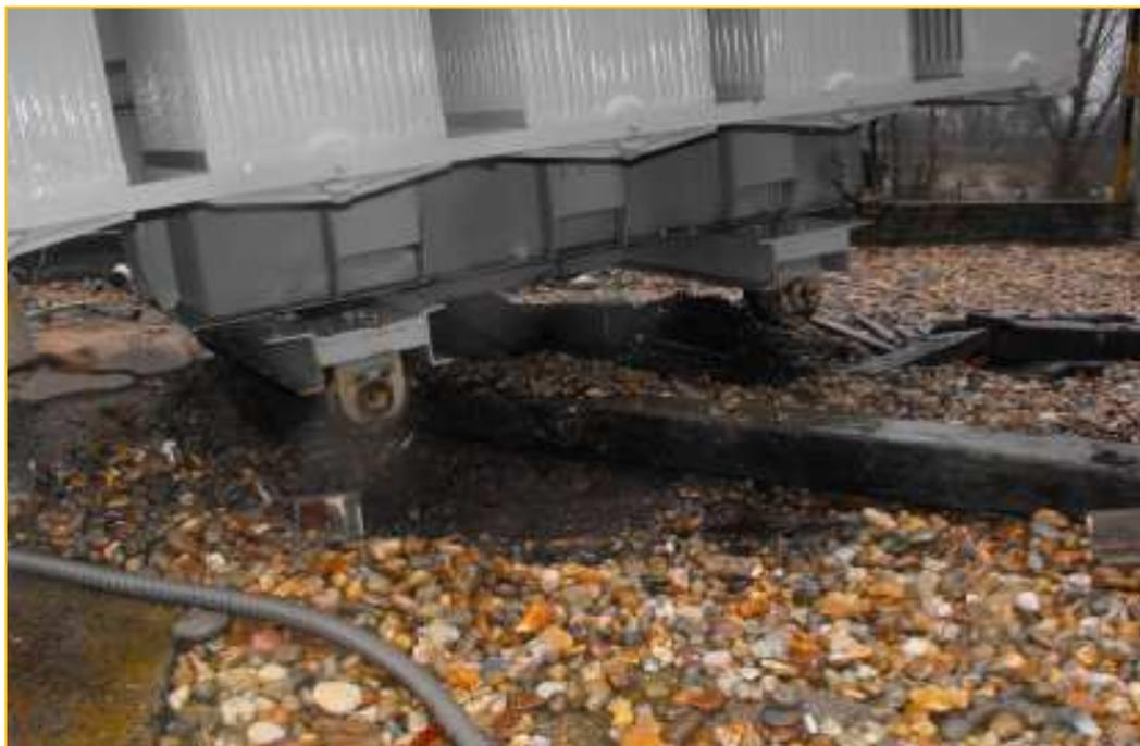
Fotografía: Vertido de aceite térmico de transformador
